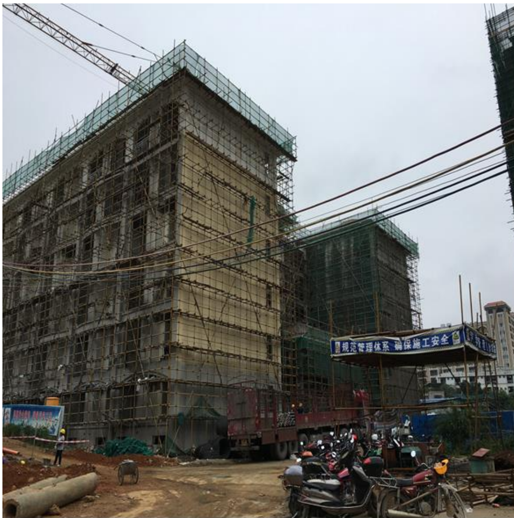
光华地块学生宿舍工地现场照片（拍摄于 5 月 3 日）
