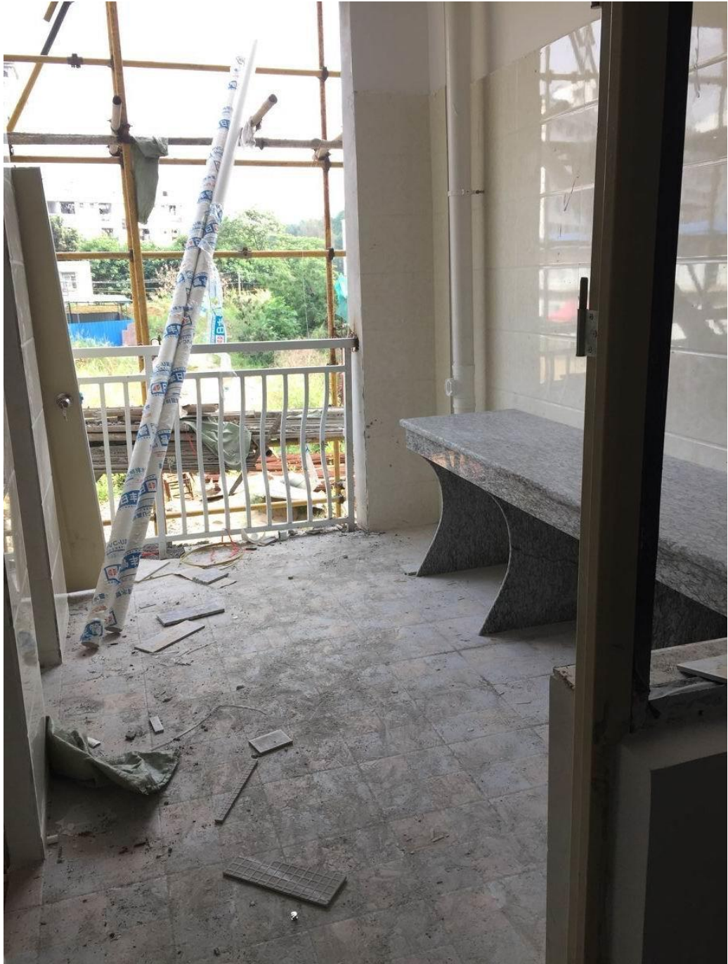
光华地块学生宿舍工地现场照片（拍摄于5月3日）
