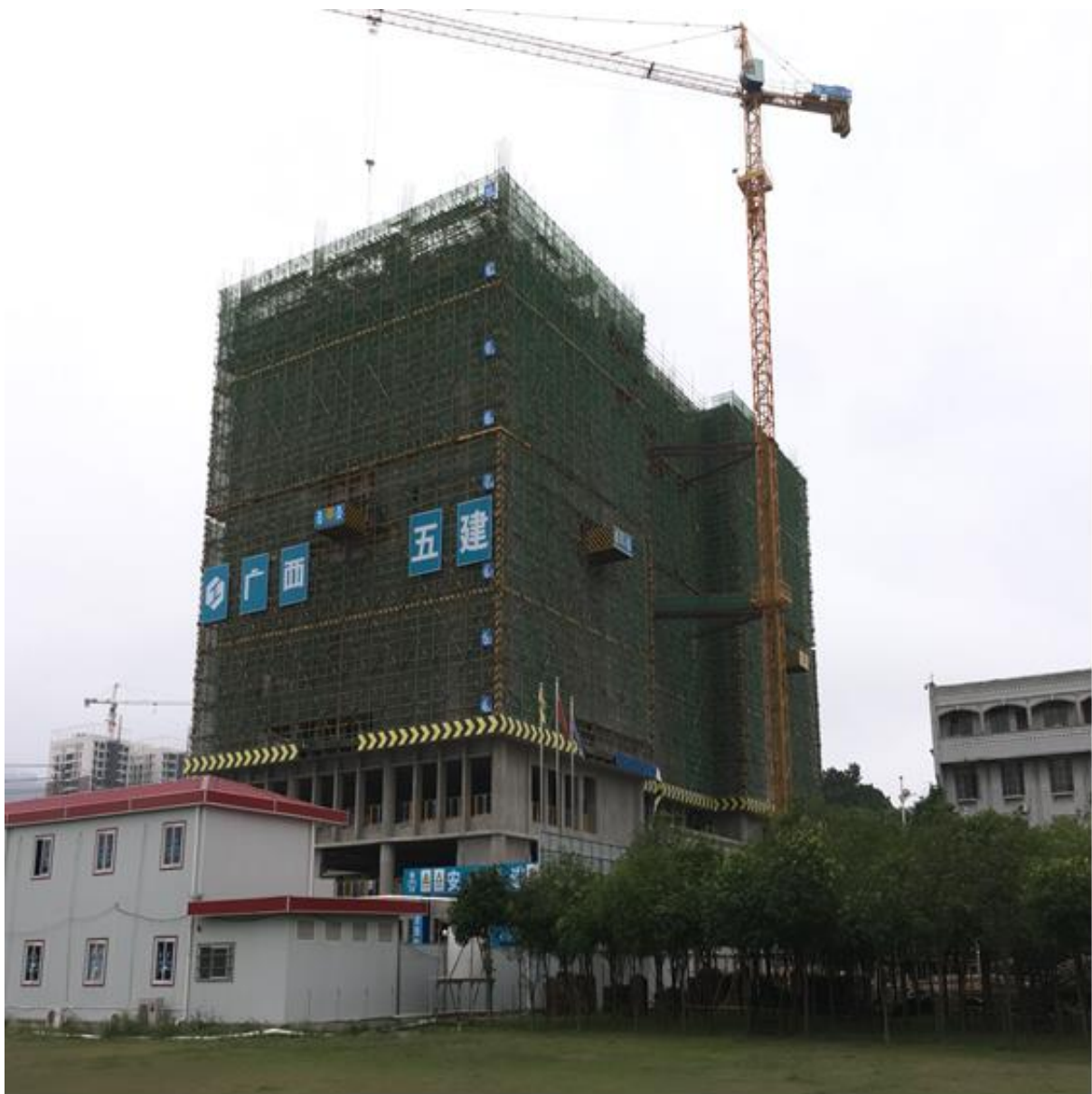
科技大楼工地现场照片（拍摄于 4 月 26 日）
