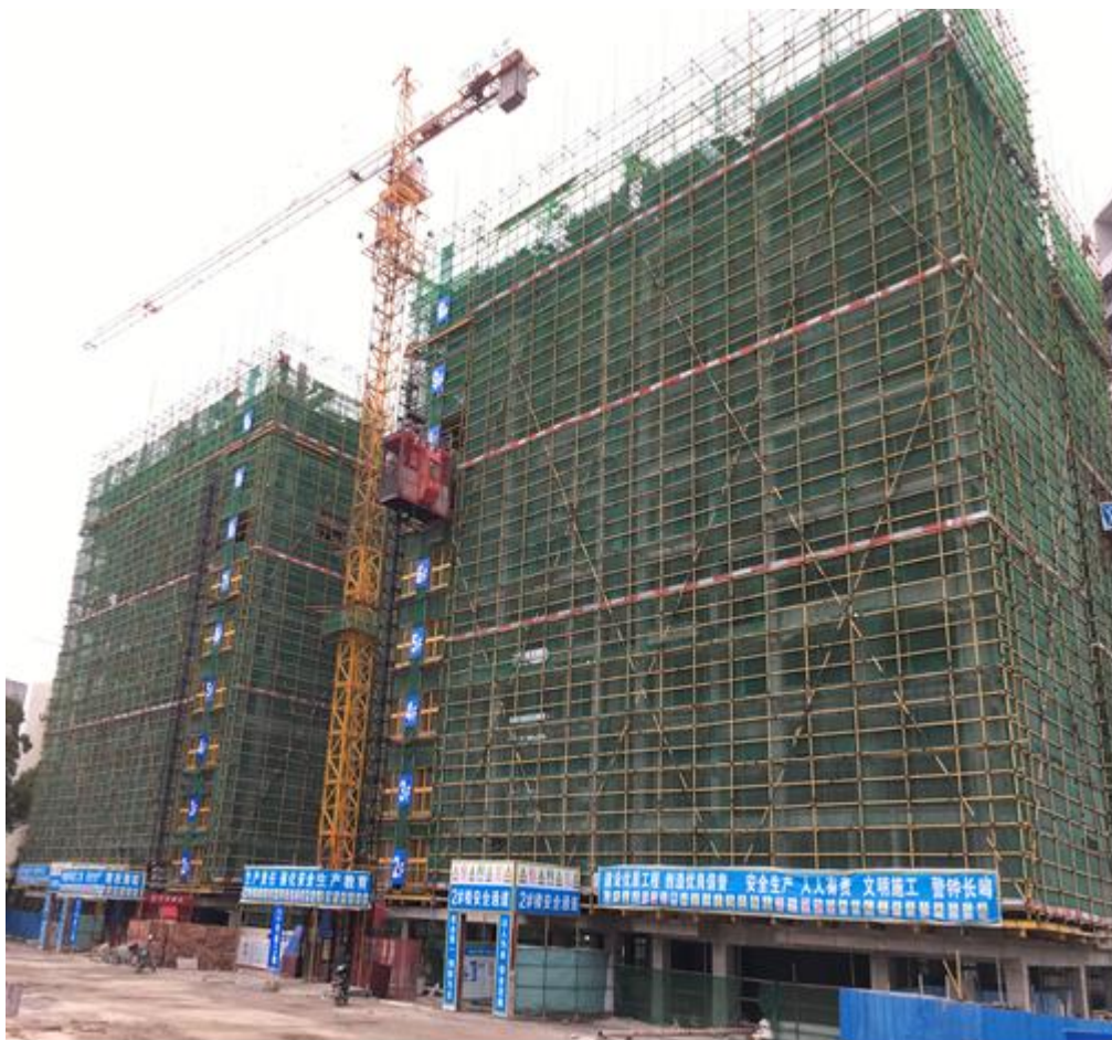
工地现场照片（拍摄于 4 月 26 日）
