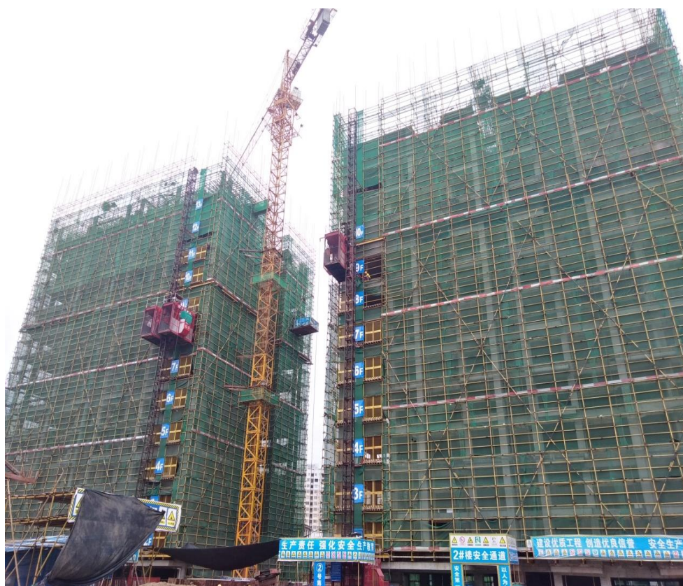
教师公共租赁房项目主体施工现场照片（拍摄于6月1日）
