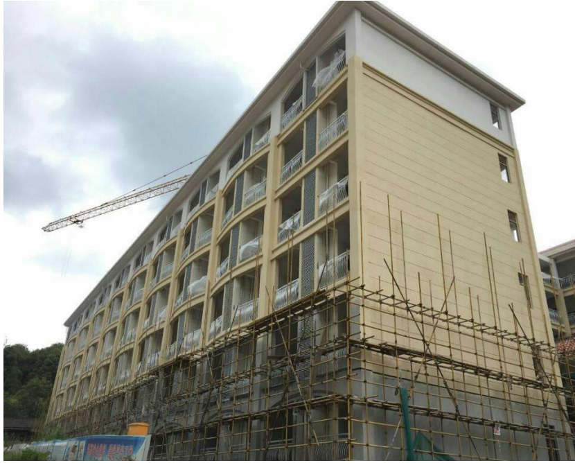
光华学生宿舍楼外墙照片（拍摄于6月2日）
