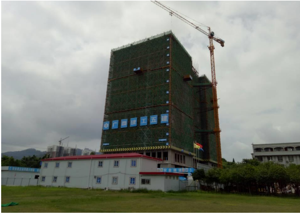
综合实验大楼（科技大楼）项目工地照片（拍摄于6月2日）
