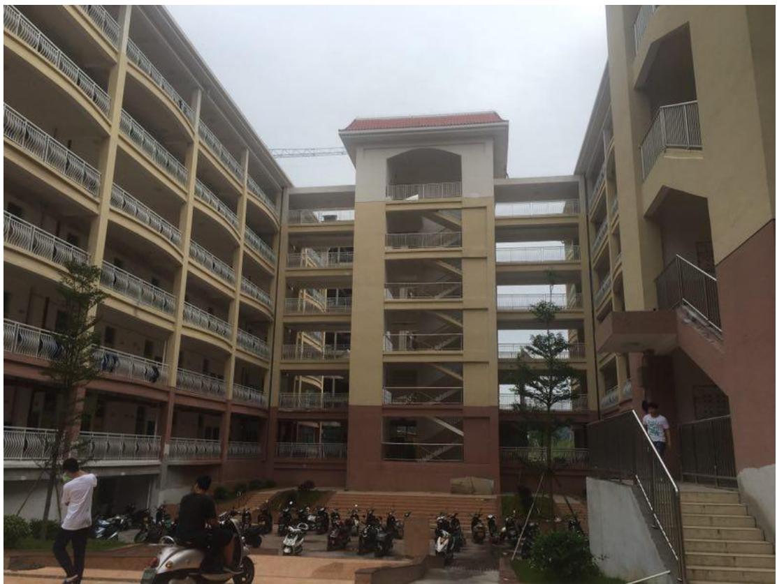
光华地块学生宿舍项目照片（拍摄于9月28日）
