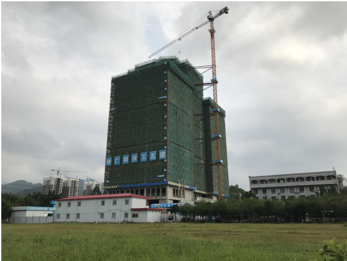
综合实验大楼（科技大楼）项目工地照片（拍摄于 9 月 27 日）
