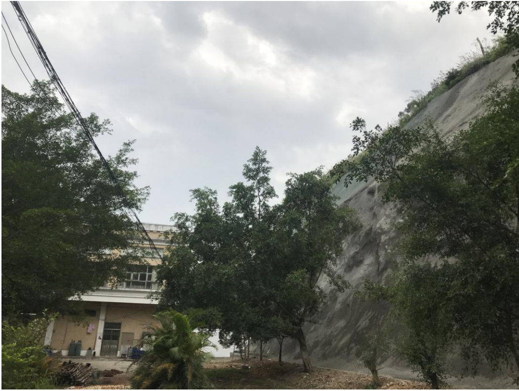
学生宿舍 A6-新食堂边坡治理工程（拍摄于 11 月 30 日）
