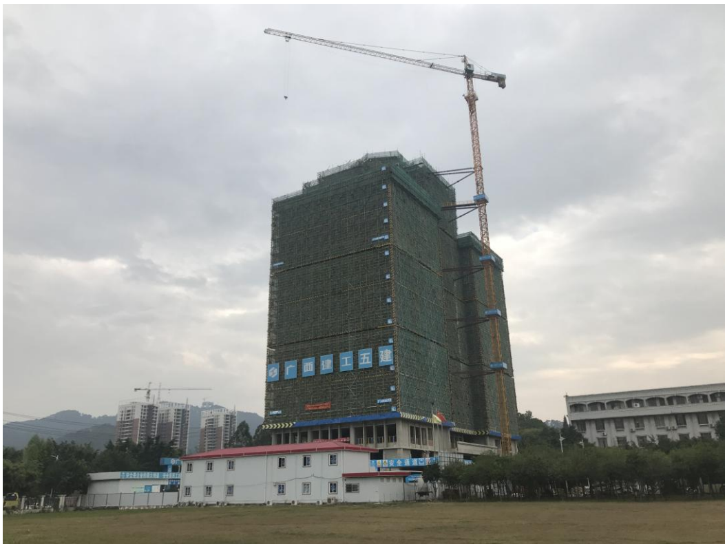
综合实验楼（科技大楼）项目照片（拍摄于 11 月 30 日）
