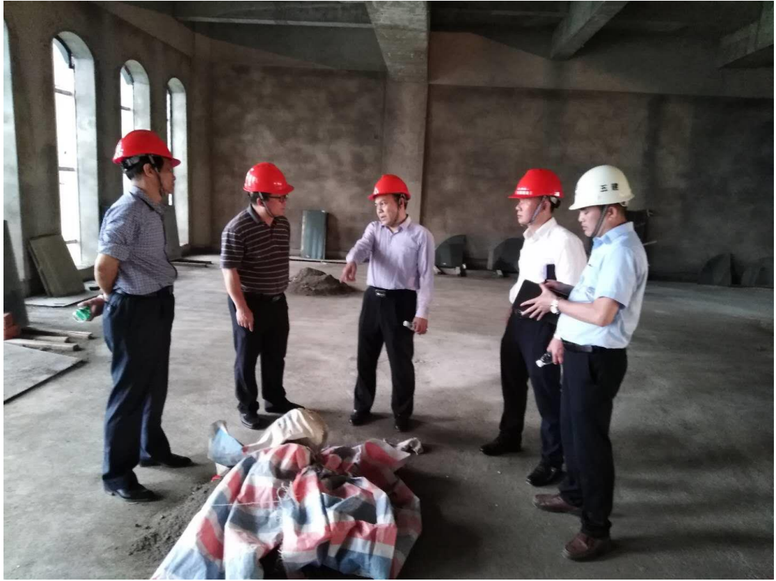
(科技大楼施工现场)
