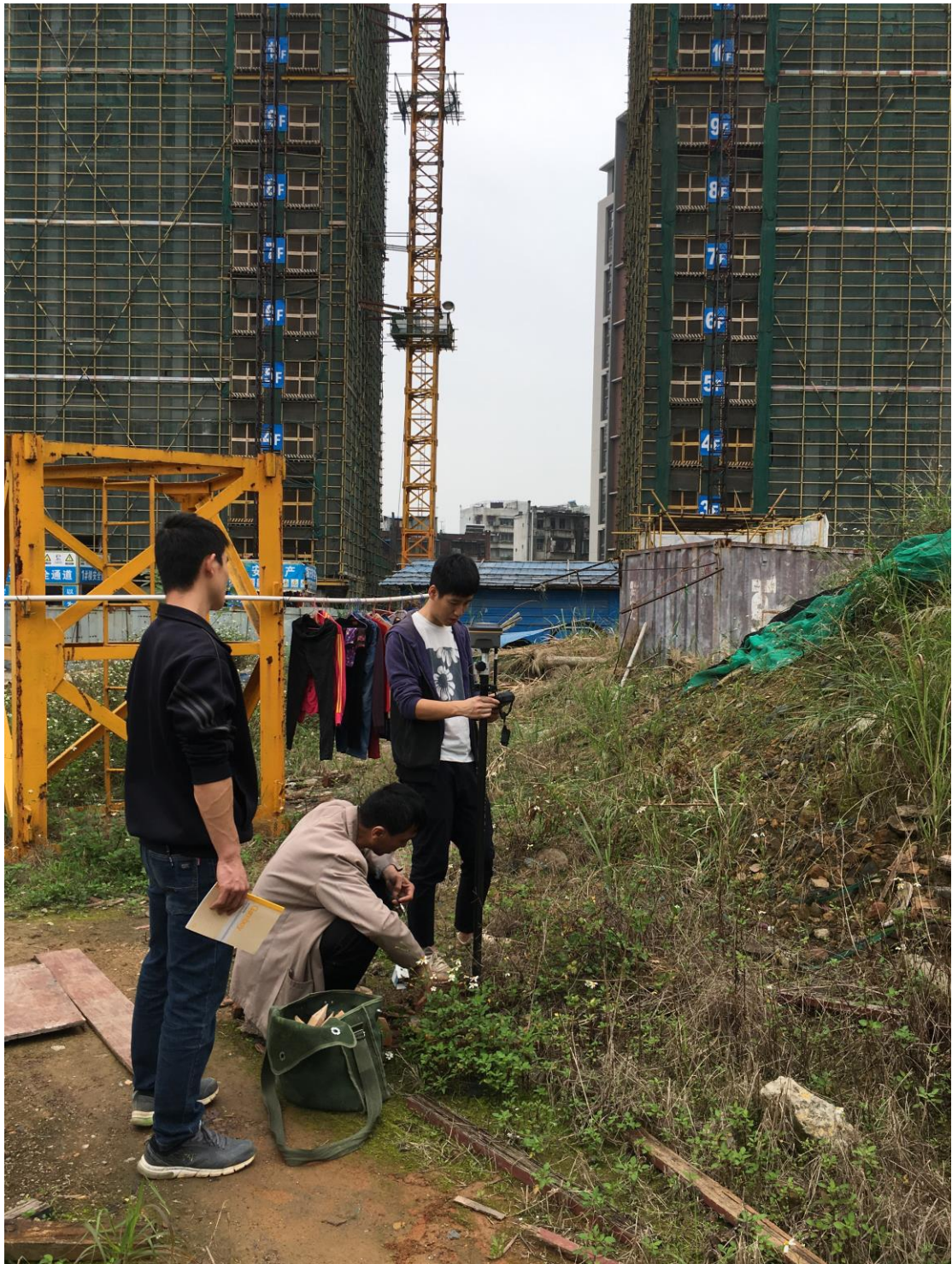
(留学生公寓现场放线)
