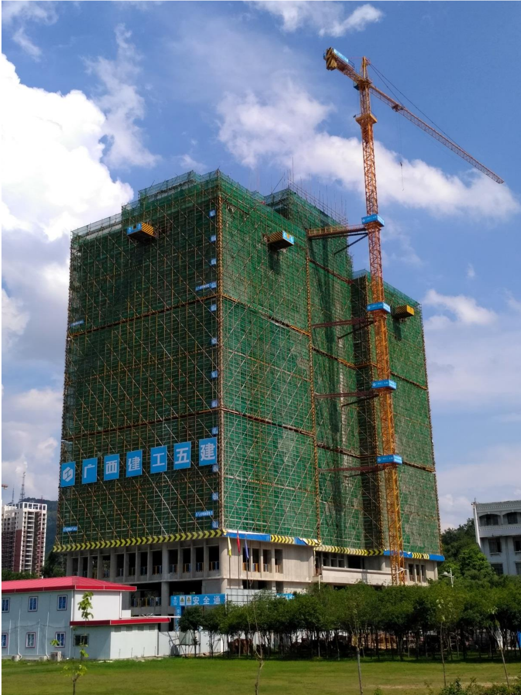
梧州学院综合实验楼（科技大楼）现场图片（摄于 2018 年 7 月 3 日）
