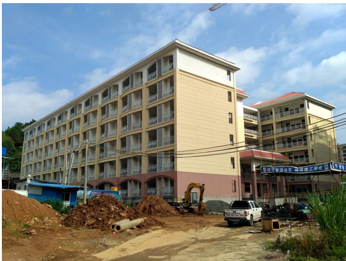
梧州学院光华地块学生宿舍项目现场图片（摄于 2018 年 7 月 3 日）
