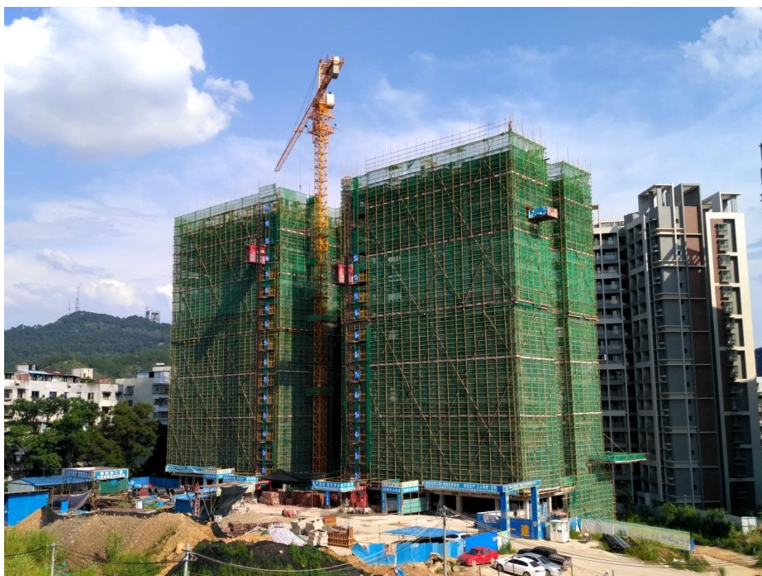
梧州市教师公共租赁住房项目现场图片（摄于 2018 年 7 月 3 日）
